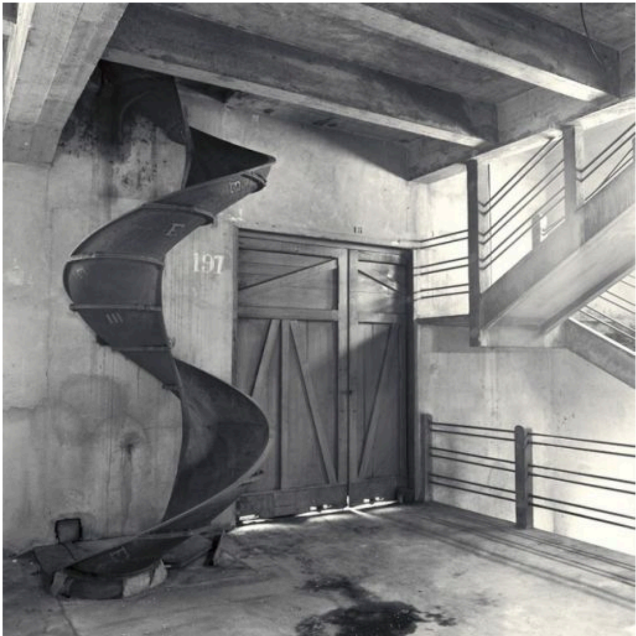
Intérieur du bâtiment de 1927 (bâtiment sud) : manutention du sucre en sac, vue du tourniquet de l'angle sud-est
