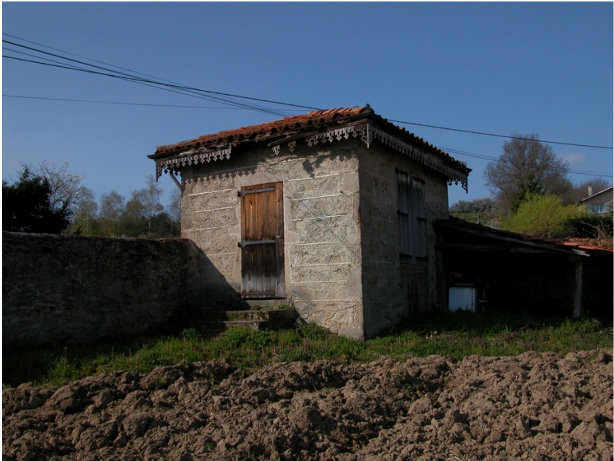
Vue d'ensemble de l'élévation antérieure, depuis l'intérieur du clos.
