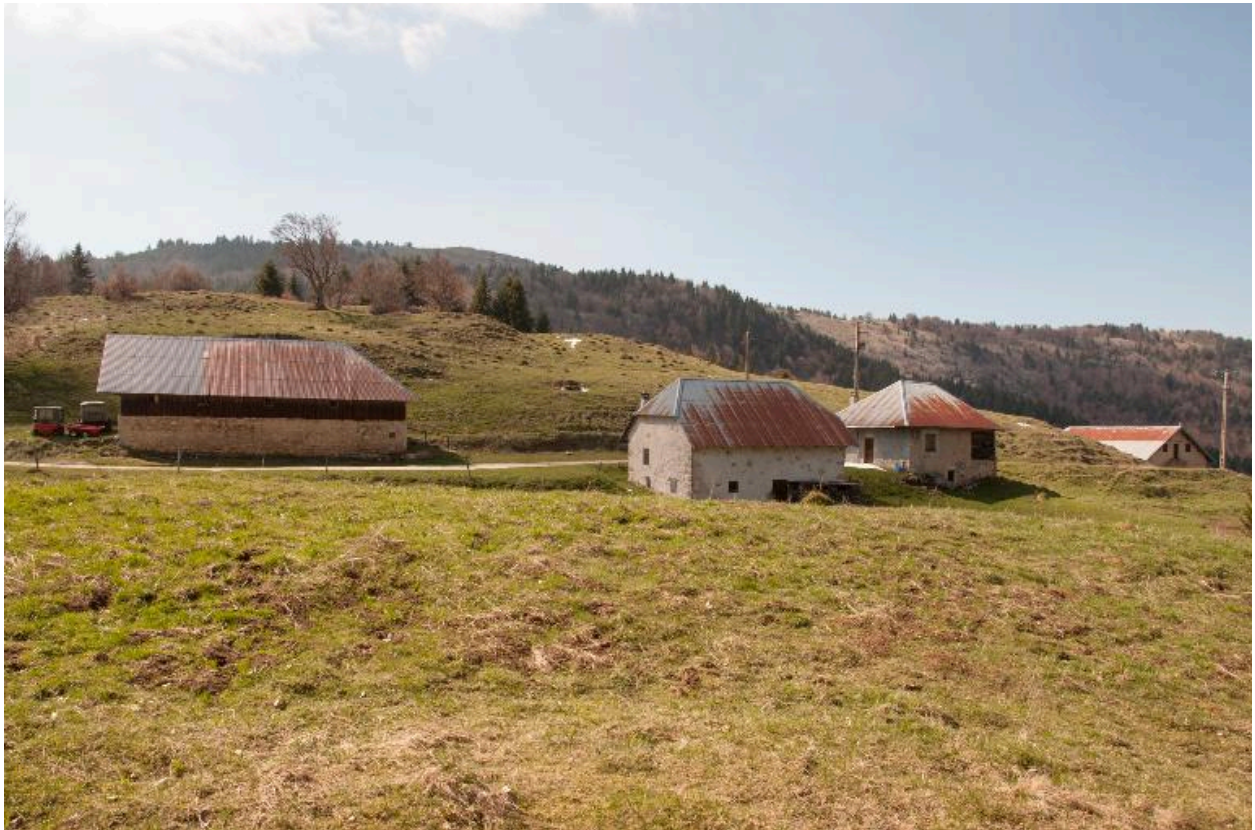
Vue générale depuis l'est.
