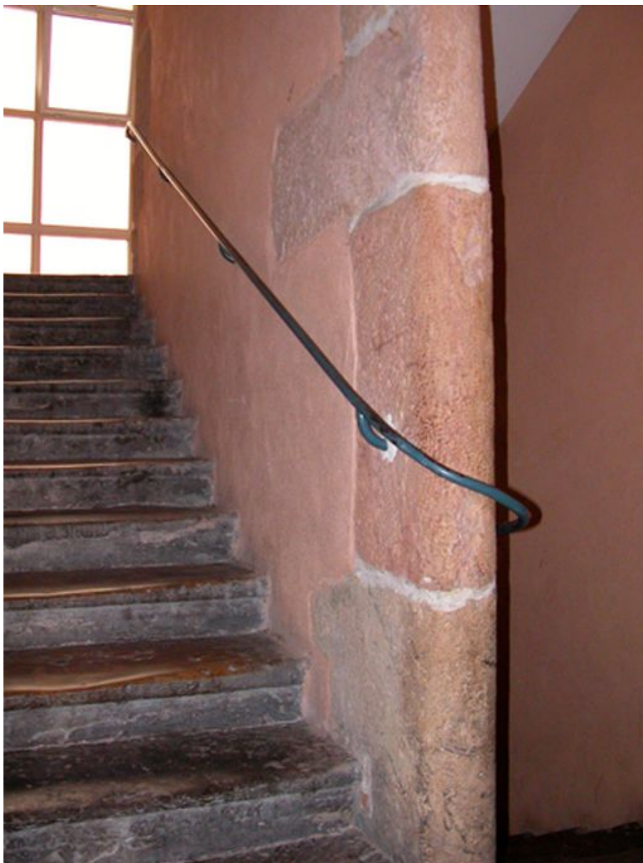
Vue de l'escalier au 1er étage
