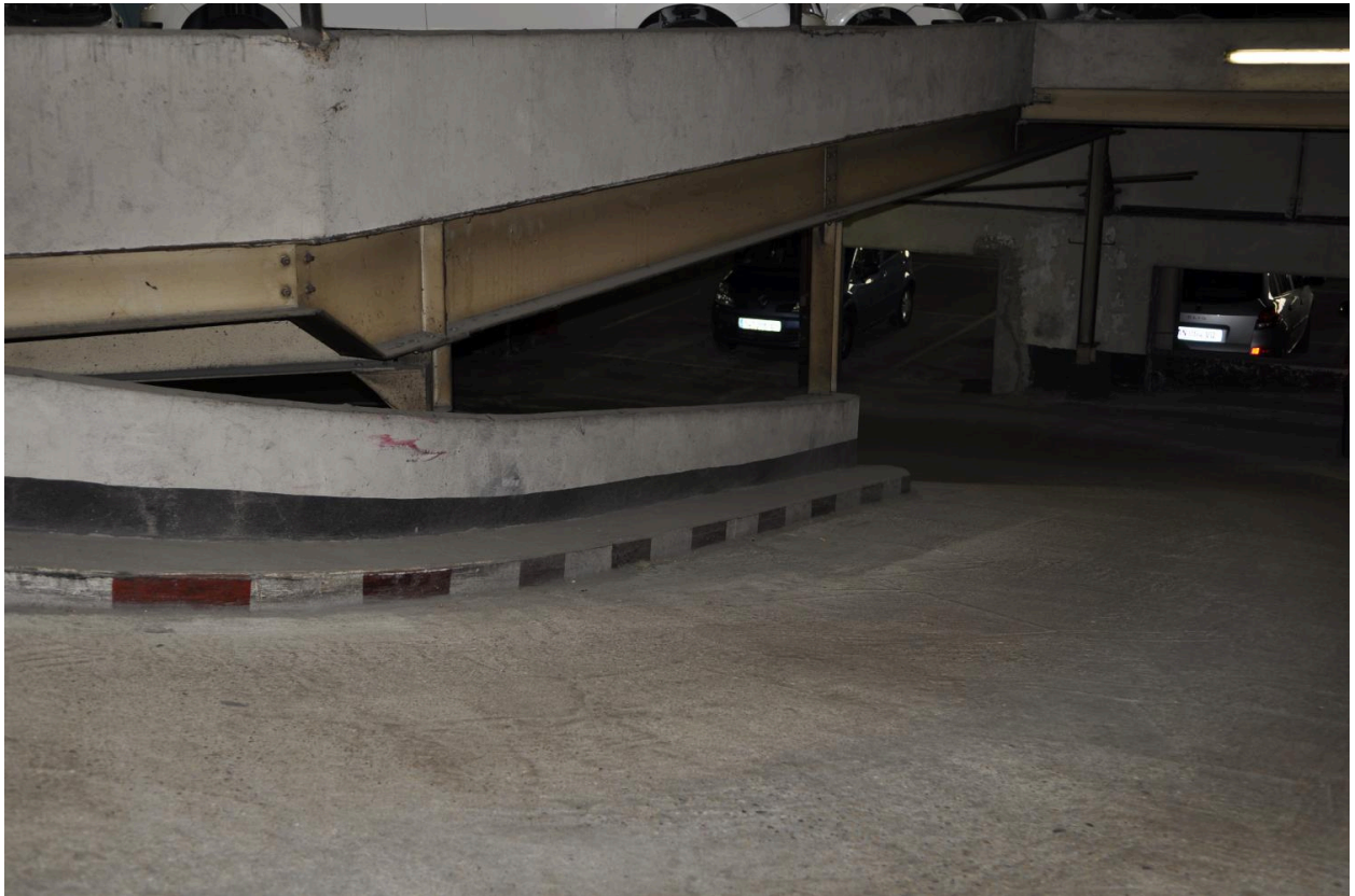
Vue intérieure du parking souterrain avec rampe d'accès
