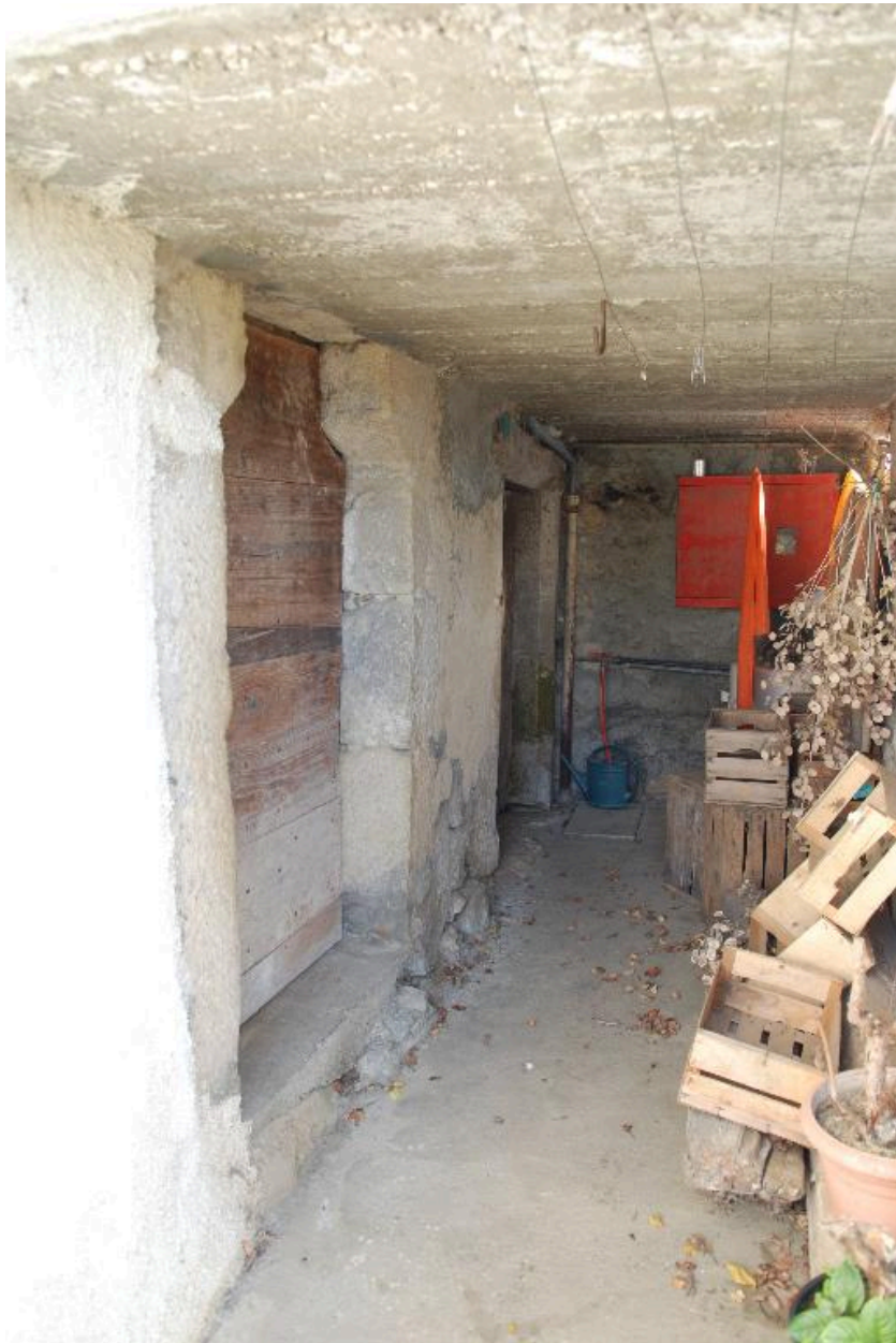
Résine (la), ferme 2014 B3 386 à 388. Vue d'ensemble des baies de l'étage de soubassement.
