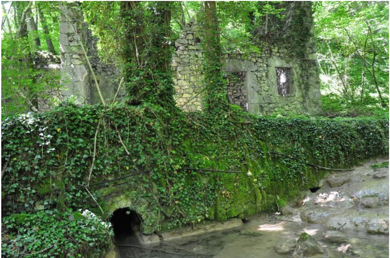
Débouché du canal de fuite du moulin dans la berge du ruisseau.
