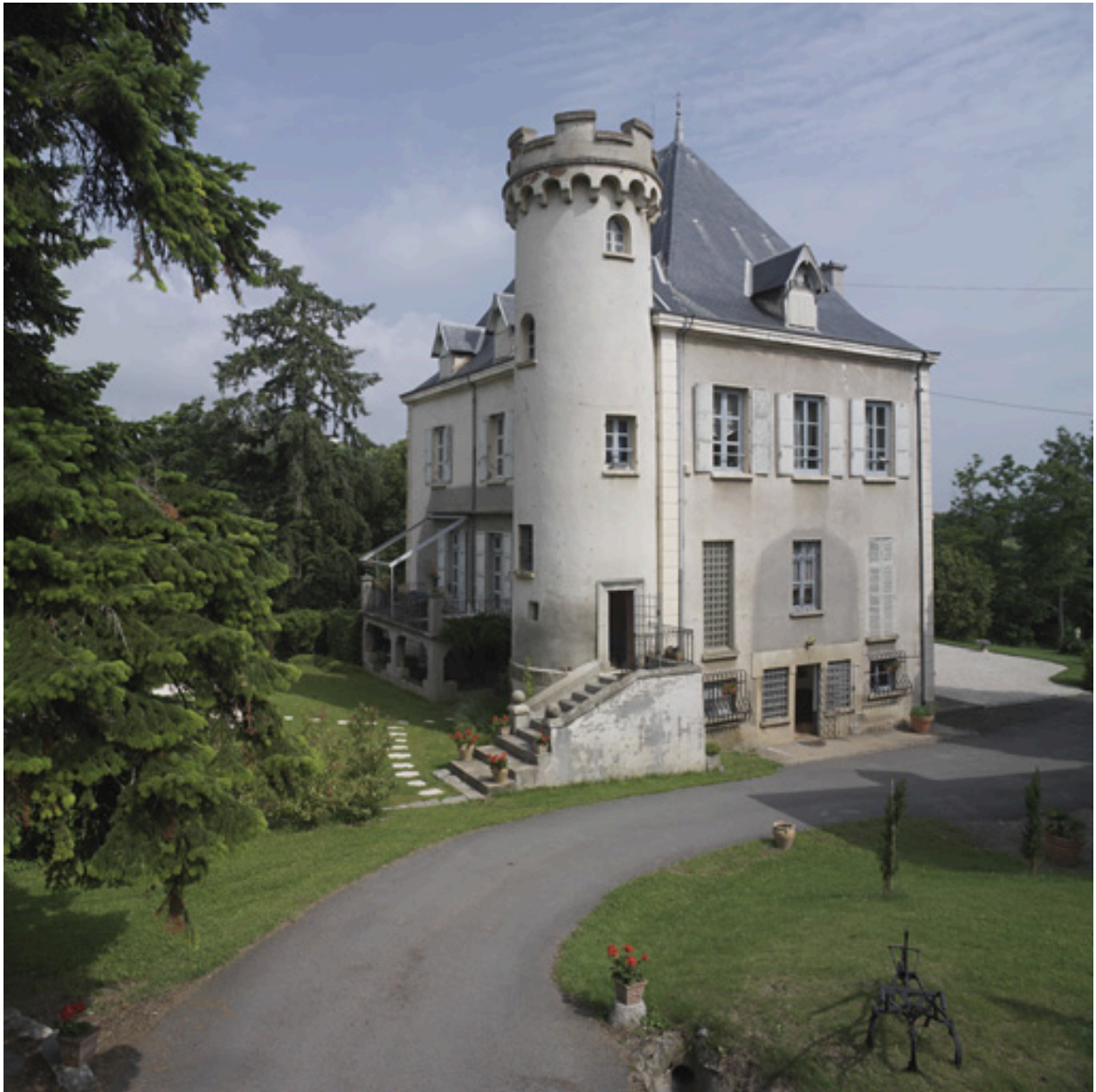
Château vu du sud-ouest.
