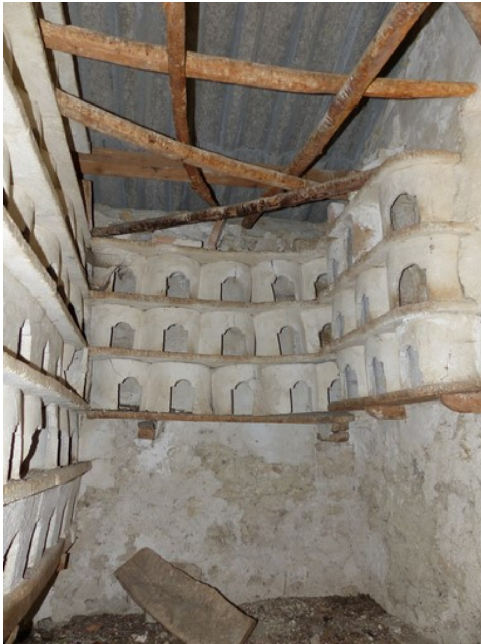
Etage de comble. Vue de volume prise de l'ouest.
