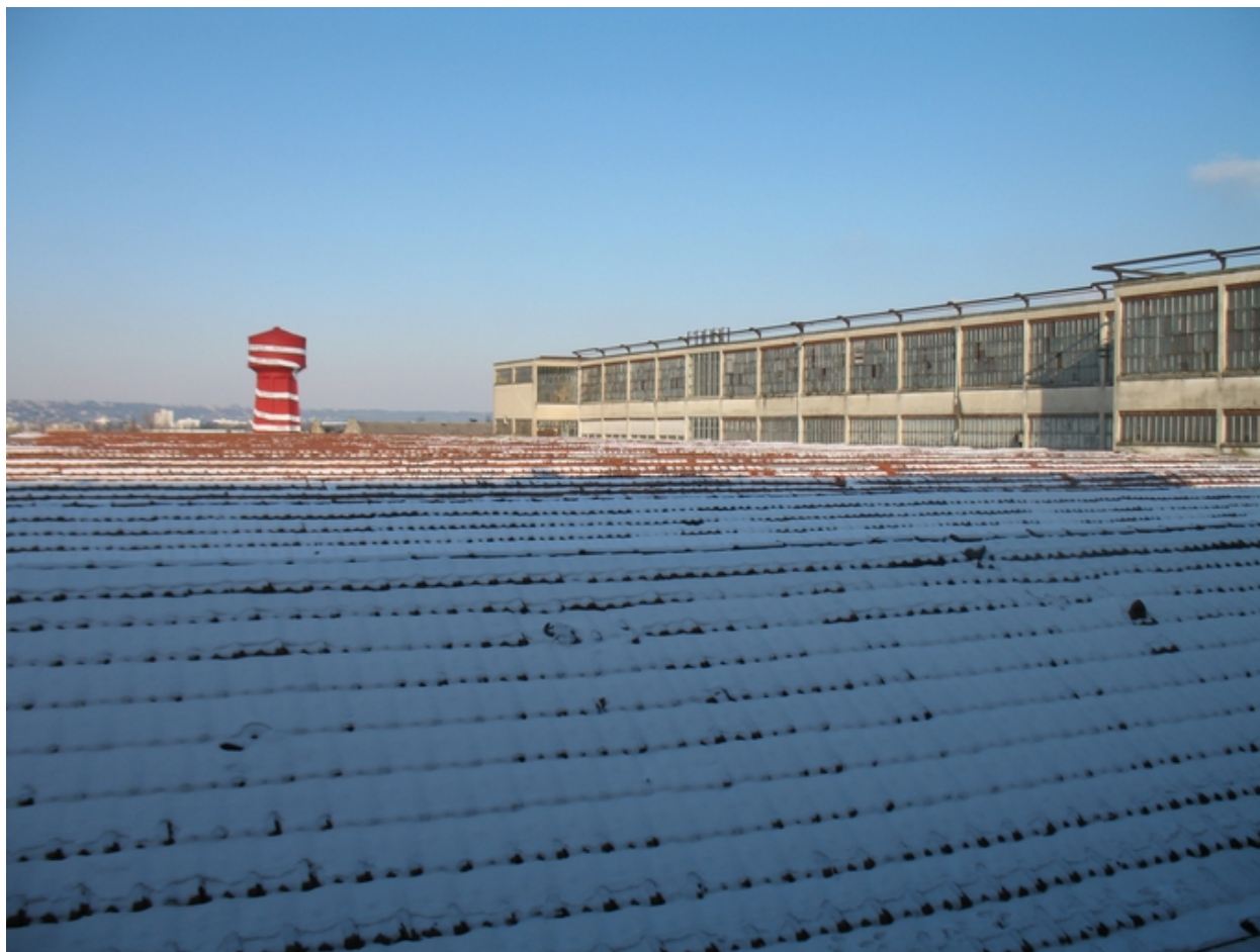
Vue d'ensemble sud des toits du site en fond le château d'eau
