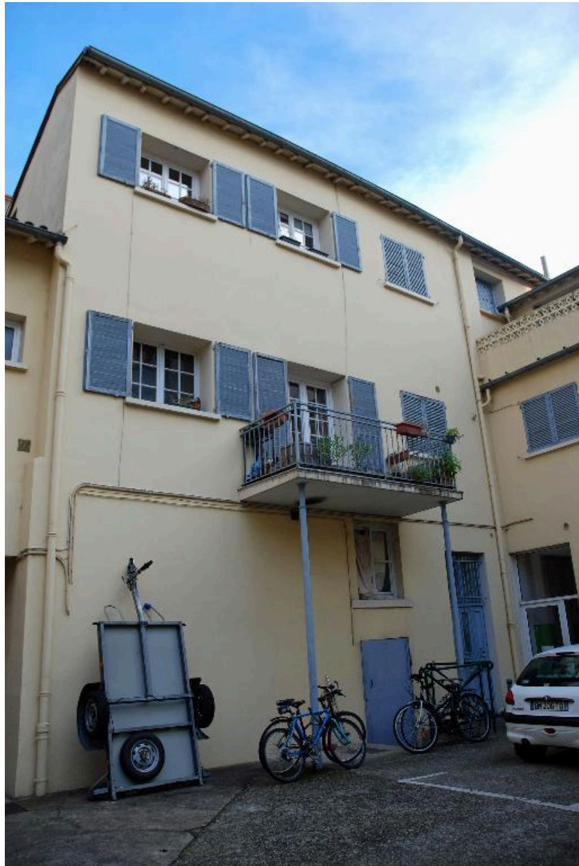
14, rue d'Aguesseau : élévation sur cour
