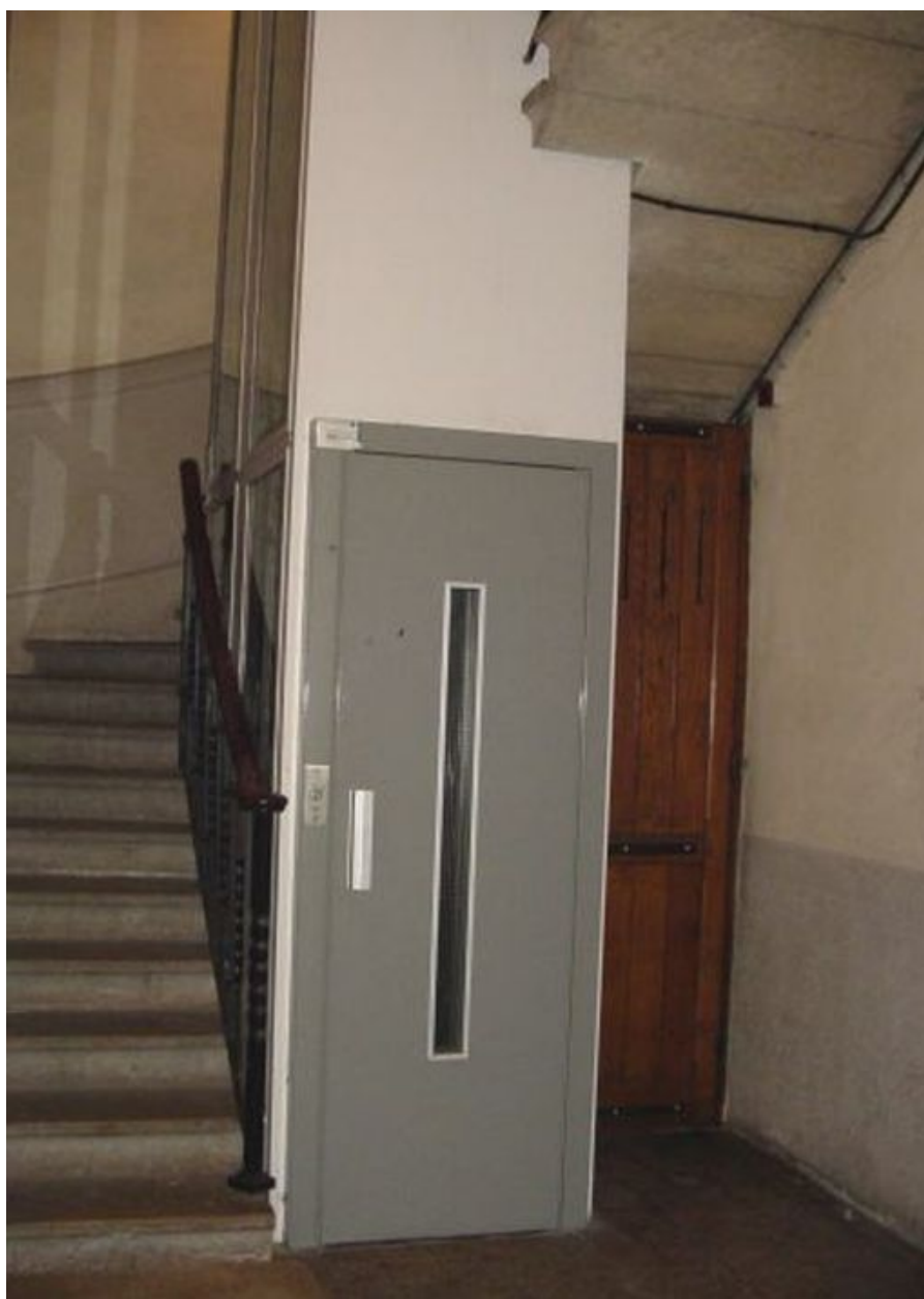
Ascenseur et départ de l'escalier
