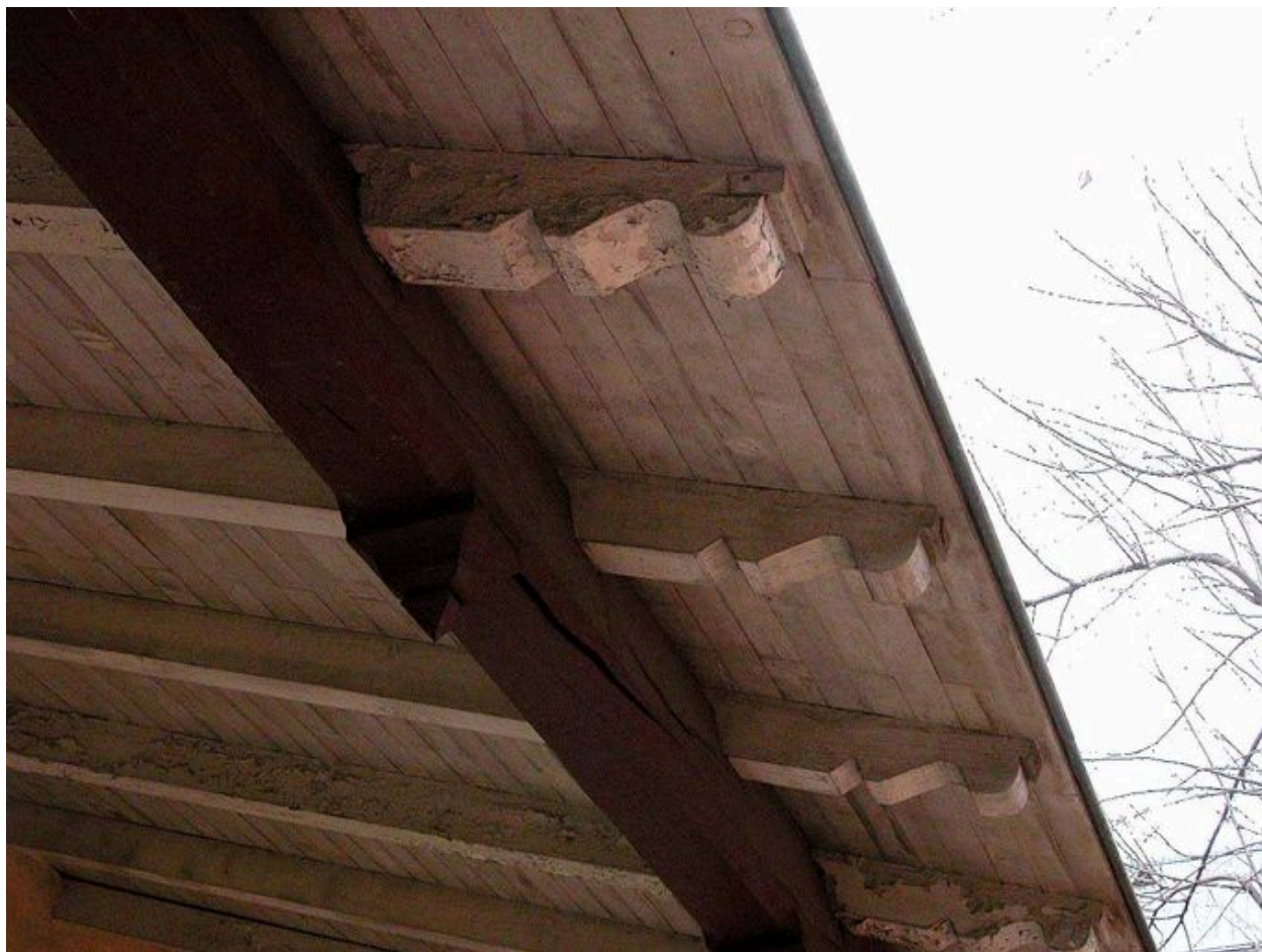
Cour nord-ouest, portique nord, détail de la sablière (avant travaux)
