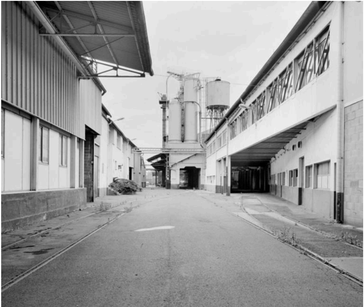
Vue d'ensemble intérieur, silo
