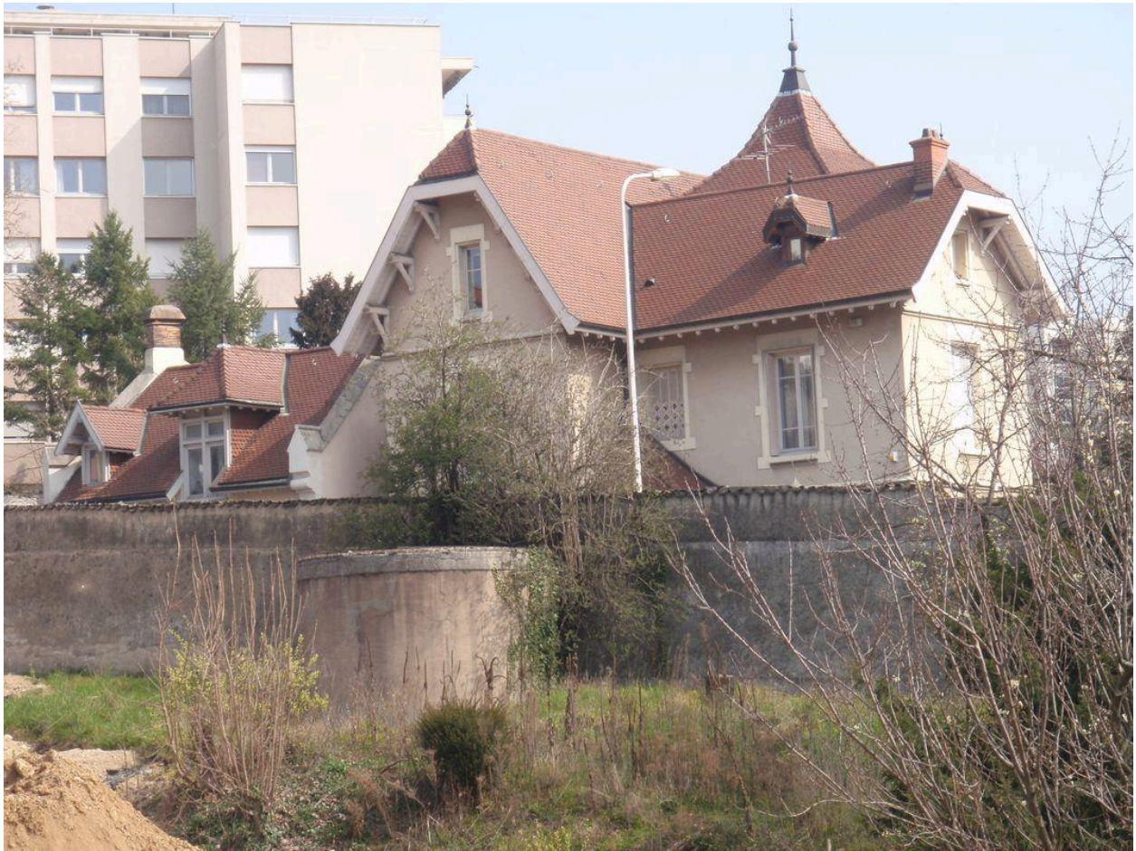
Tour aérateur-ventilation du tunnel de Fourvière
