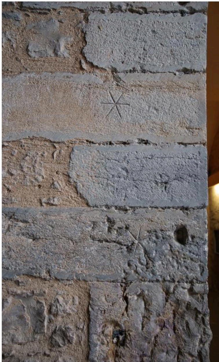
Escalier D, 1ère volée : marque tacheron
