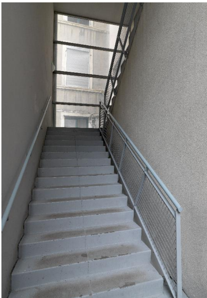
Cour des cuisines, escalier hors-oeuvre (escalier I), 1ère volée
