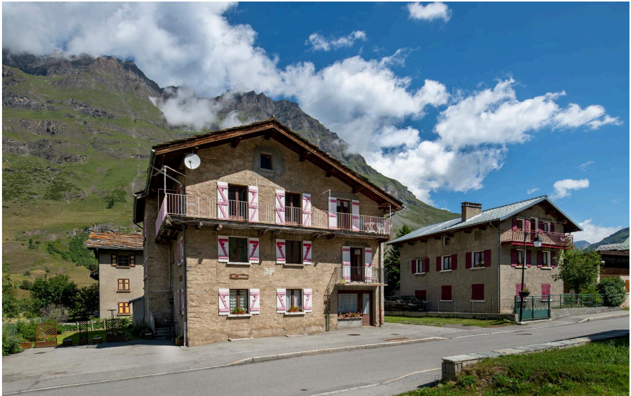
Vue sud-est de la maison d'Etat de Simone Tracq
