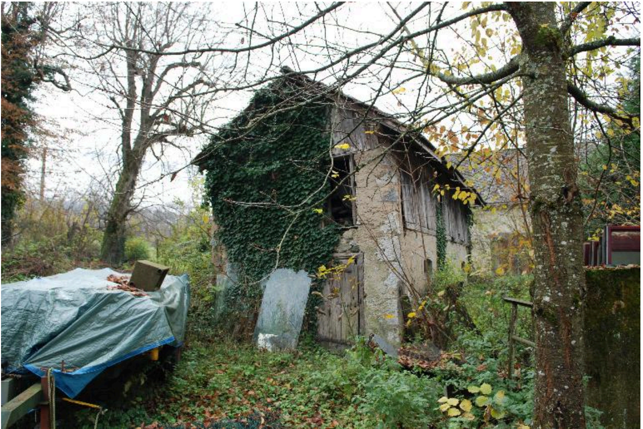
Remise de la ferme avec porte en remploi.
