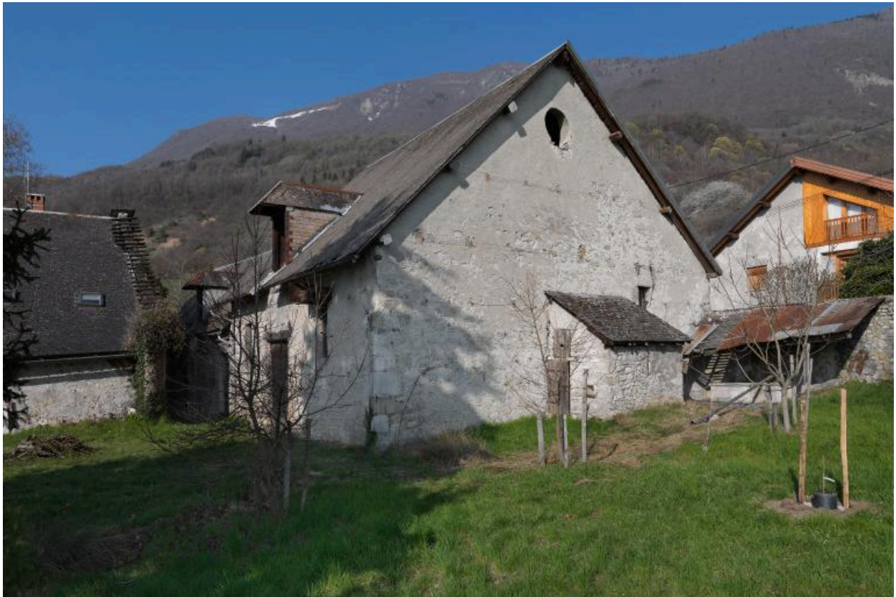
Vue d'ensemble des communs de trois-quarts avant droit.
