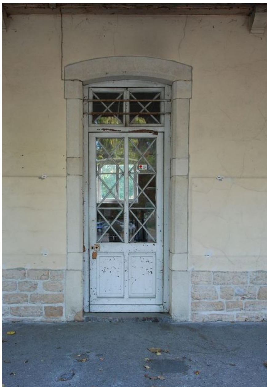
Porte du parloir du quartier des hommes (bâtiment 302)
