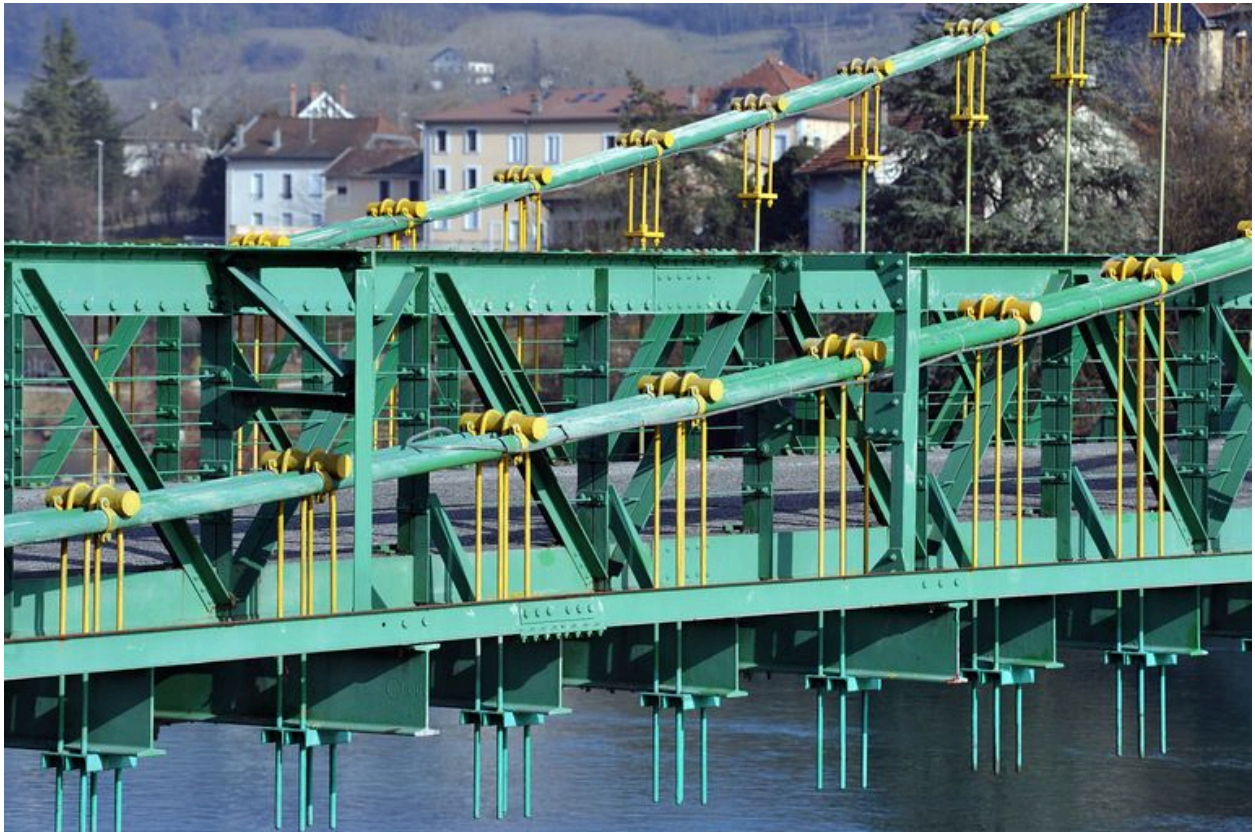
Travée droite, face aval, vue partielle : tablier, parapet et câbles porteurs (depuis la rive droite)
