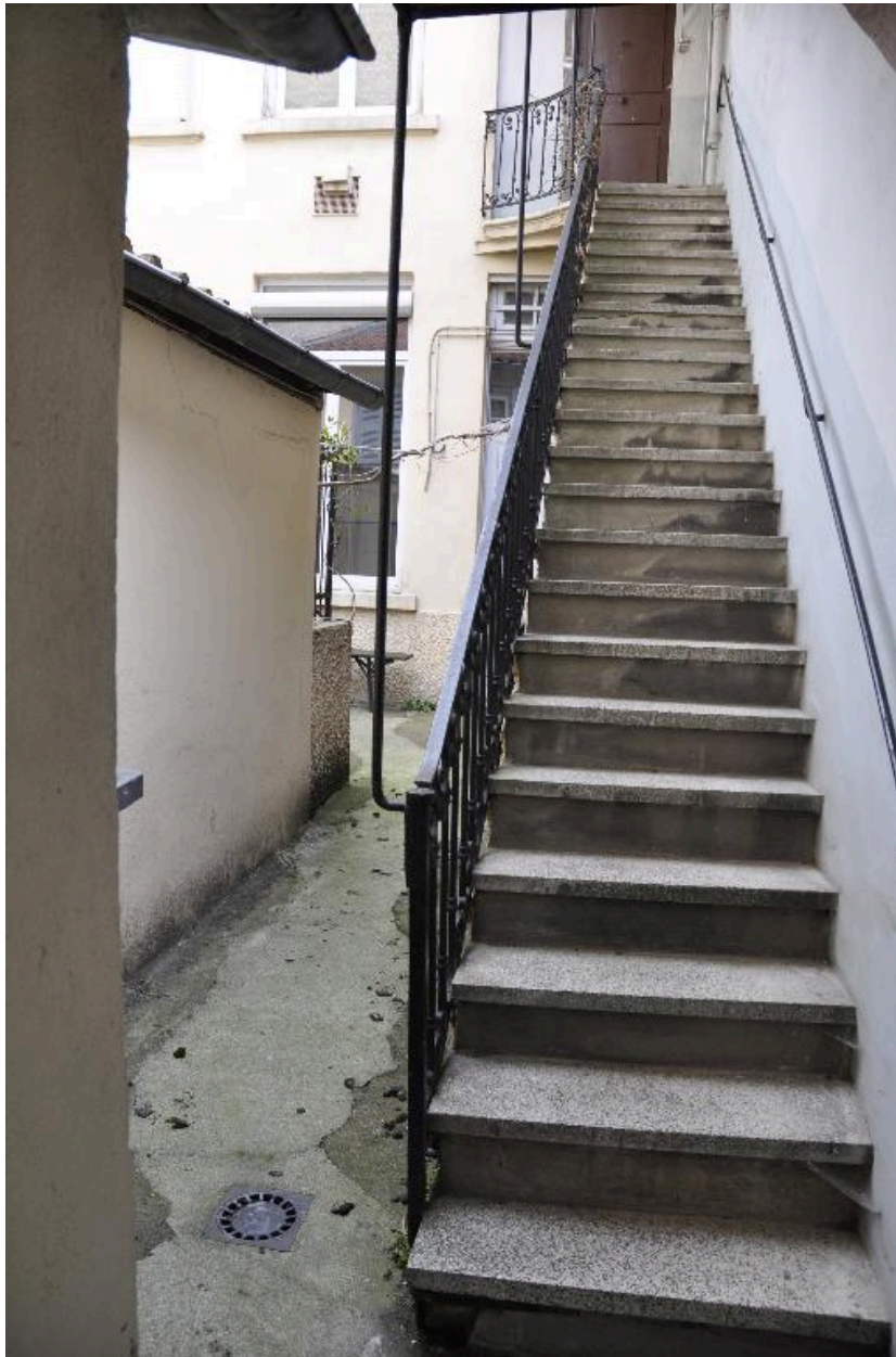
Vue de l'escalier de l'immeuble sur cour
