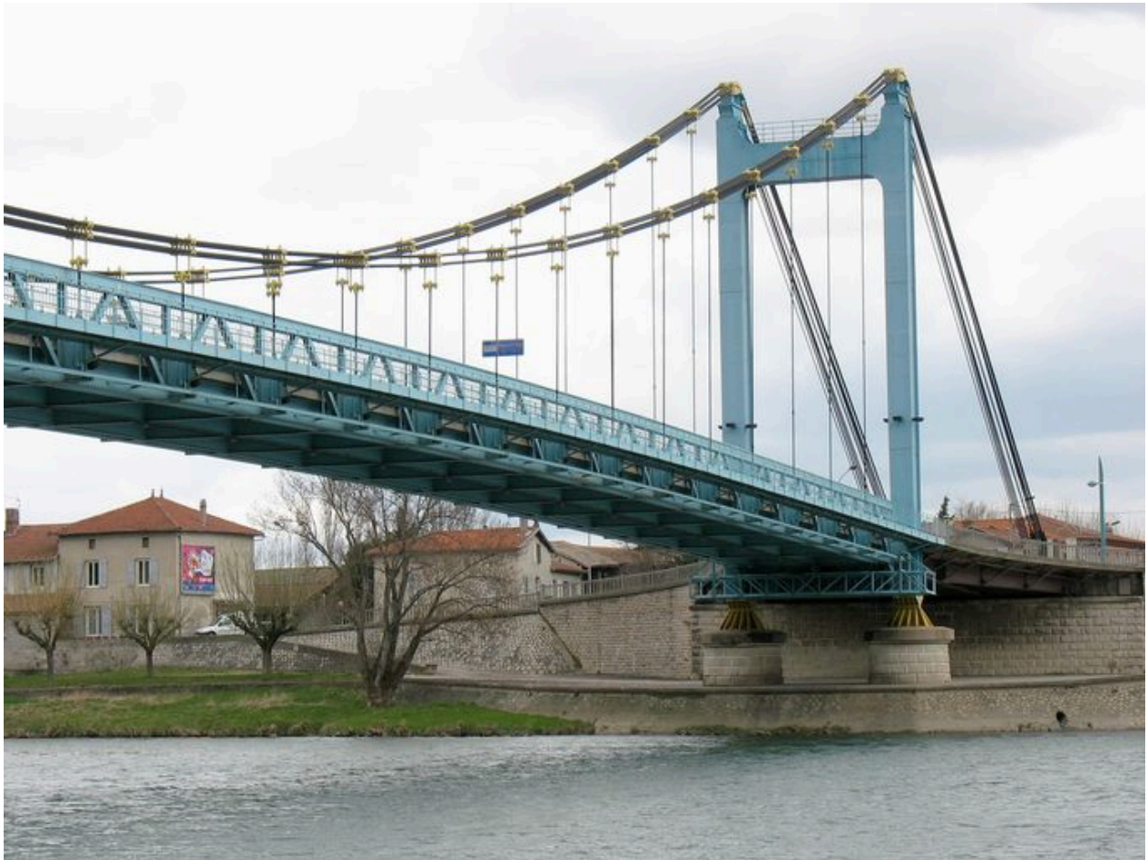
Vue partielle face aval, pylône de la rive gauche
