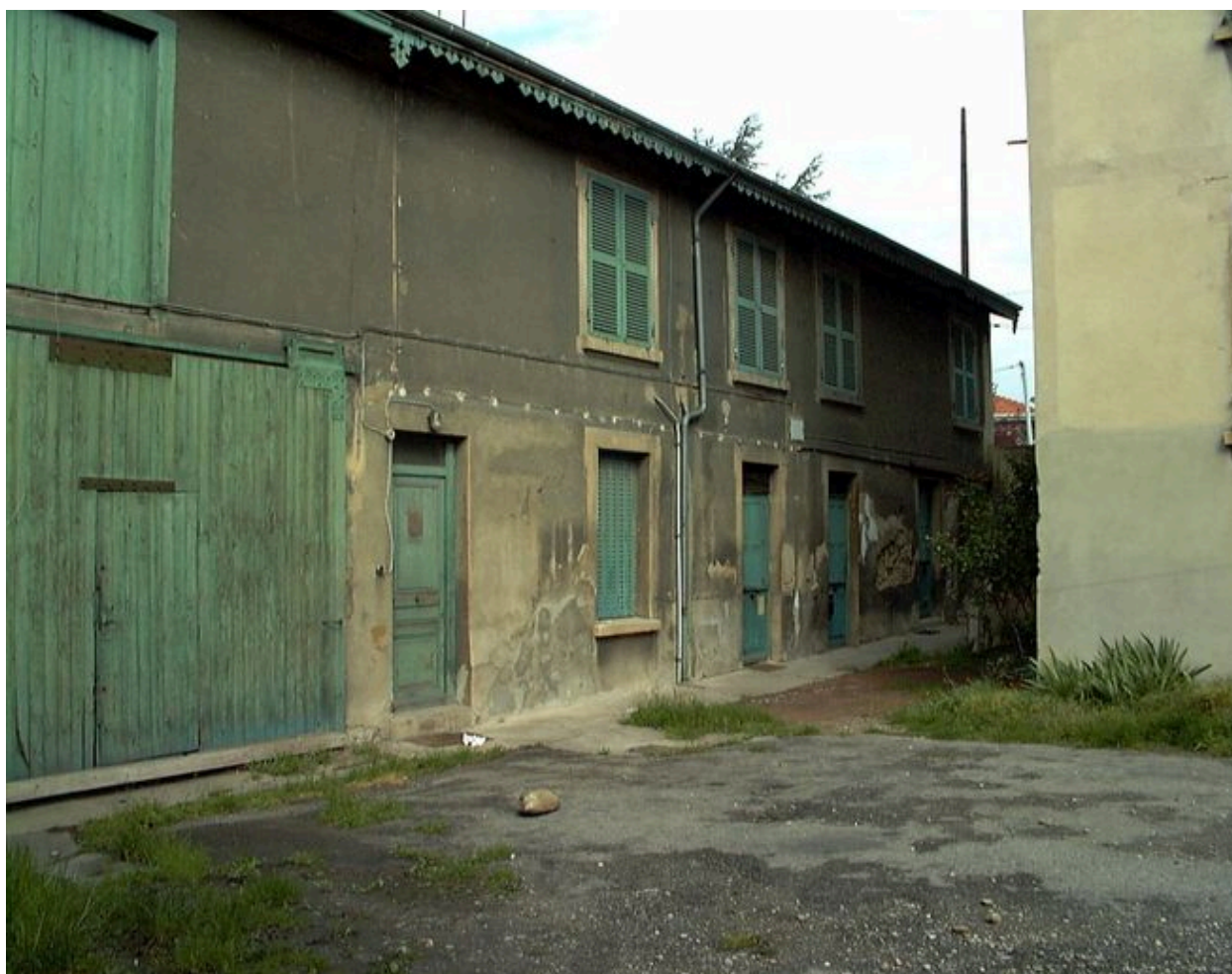
Corps de bâtiment n° 186, façade sur cour
