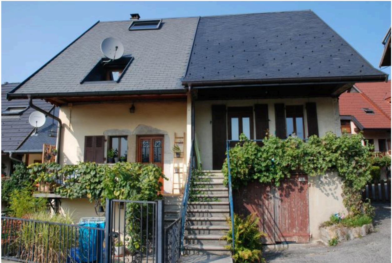
Viuz-Nord, C4 1727, 2064, 248, 922, ensemble de quatre maisons. Vue d'ensemble des bâtiments de face (façades sud) des parcelles 248 et 922.
