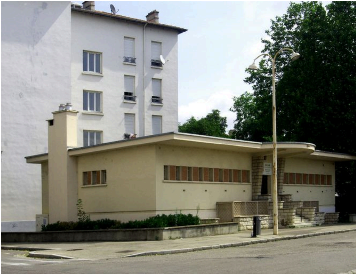
Vue générale des bains douches réalisés en 1967.
