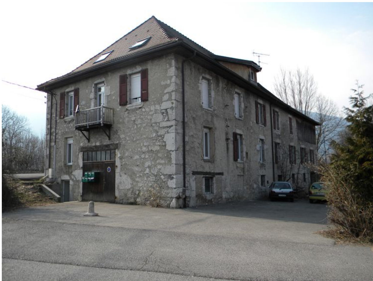
Vue de trois quarts depuis la route de la Vieille Eglise.
