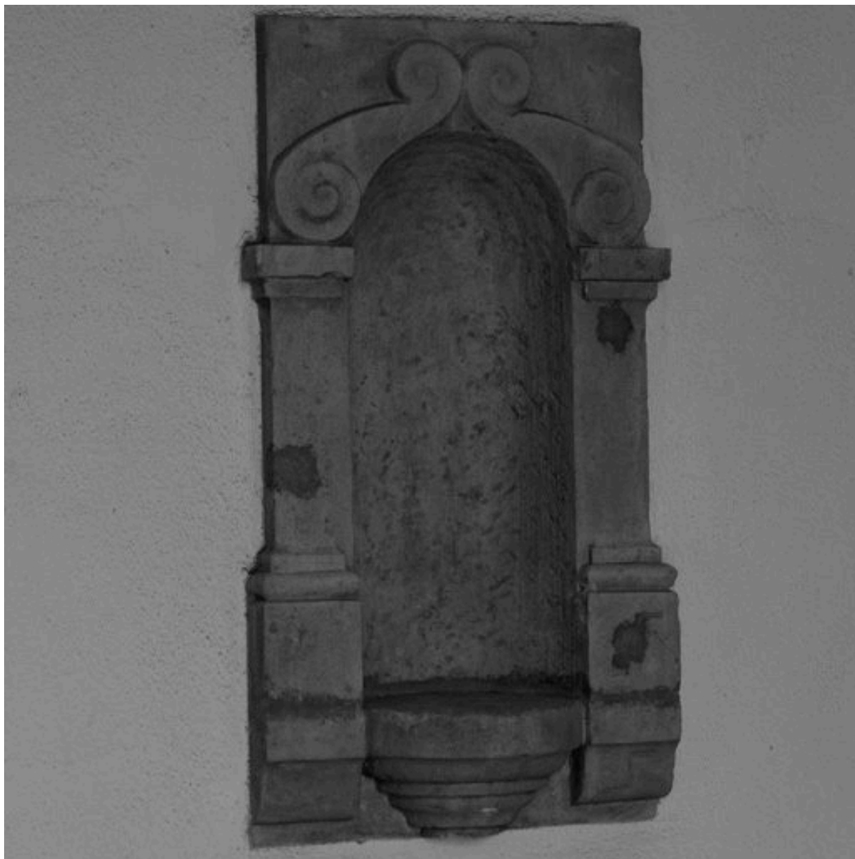
Escalier : niche d'éclairage
