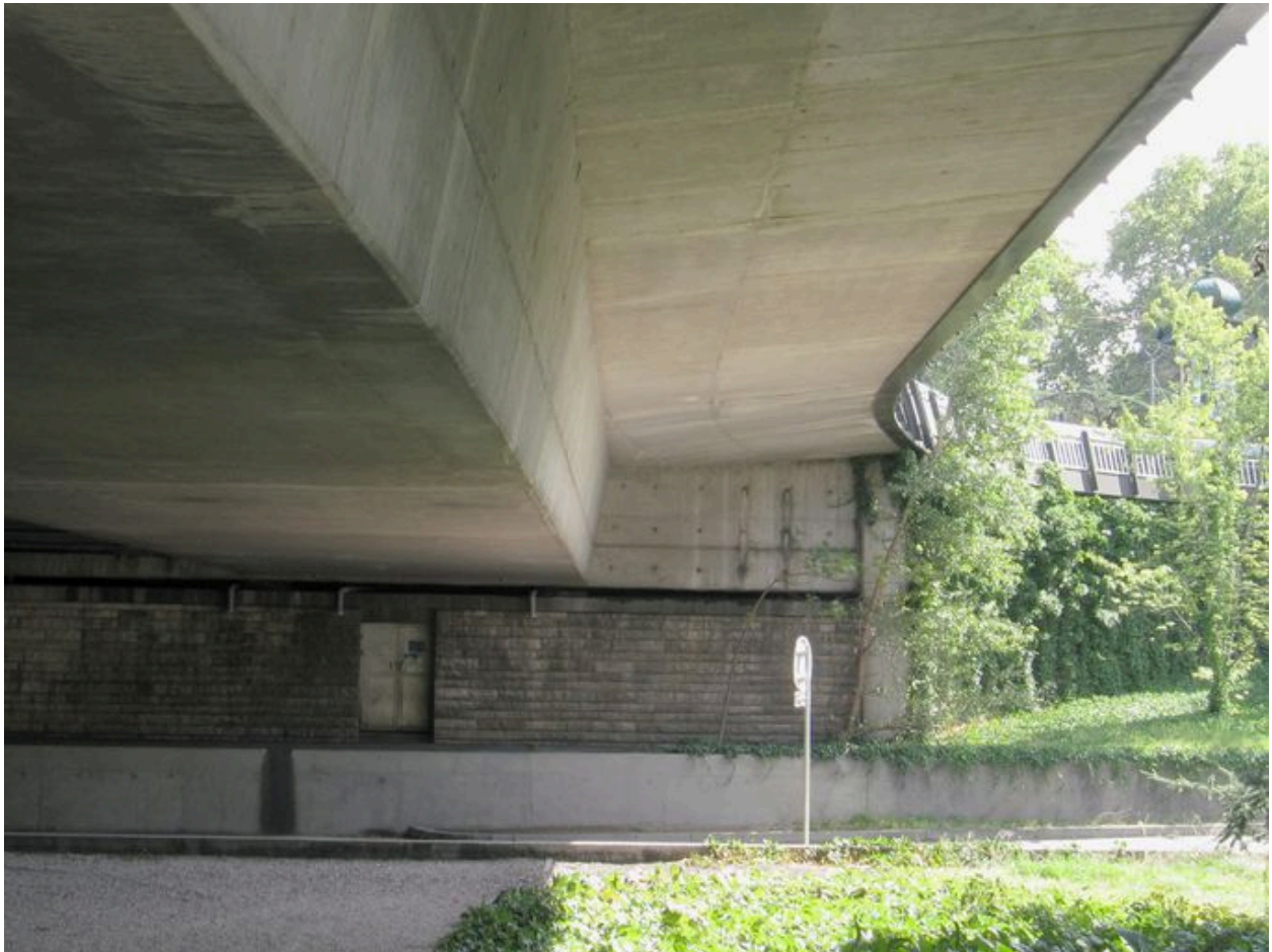
Culée gauche, de dessous, vue partielle (depuis la rive gauche)
