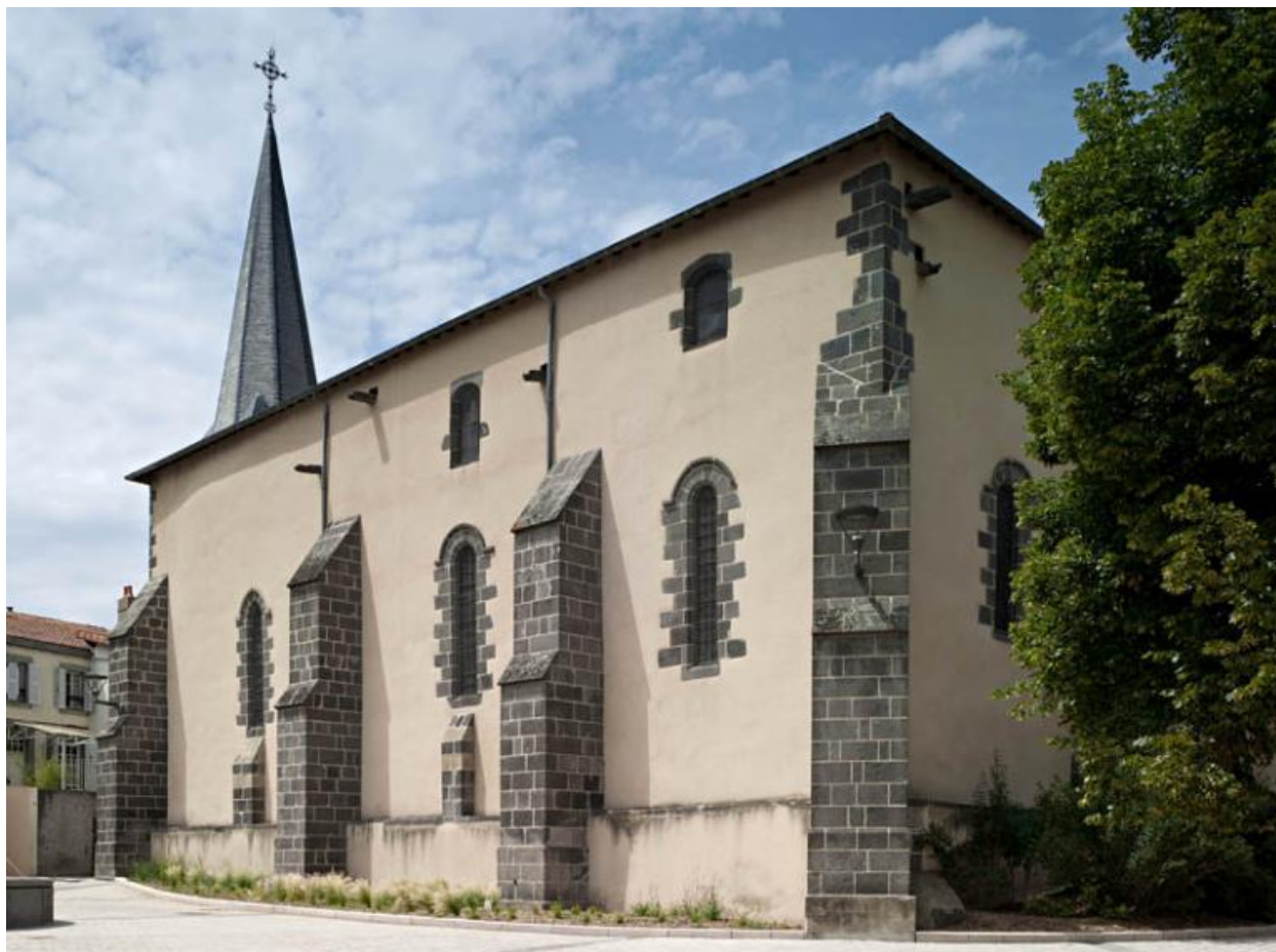
Vue générale de la façade méridionale.
