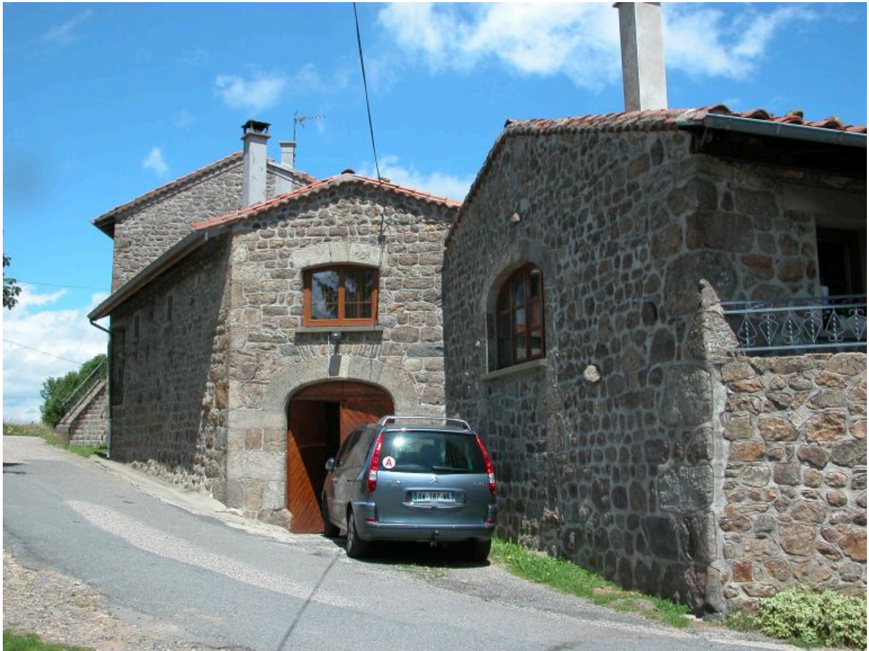
Élévation partielle latérale gauche des bâtiments (1986 AD 349).
