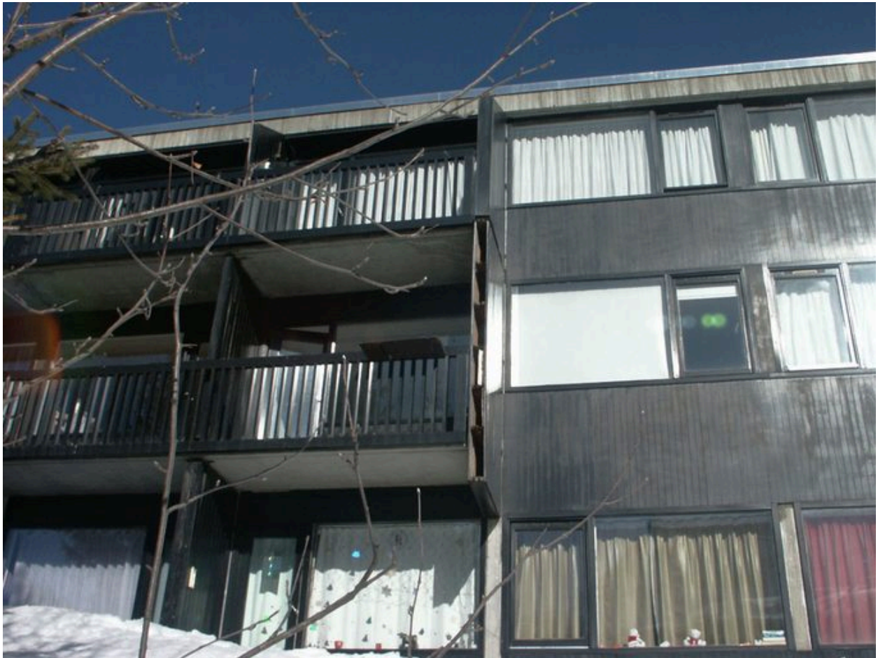
Détail des balcons sud
