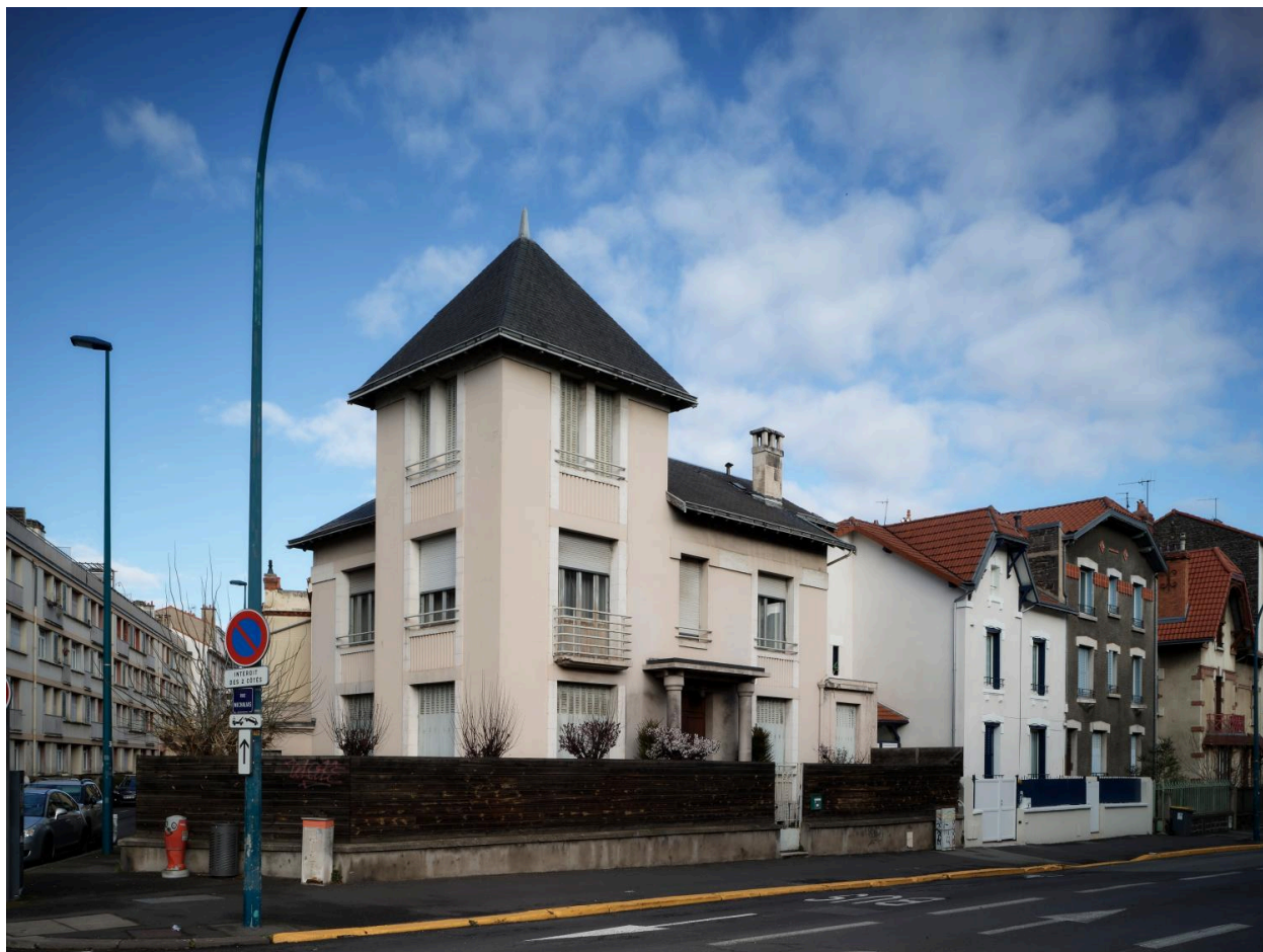
Façade sur le boulevard Fleury
