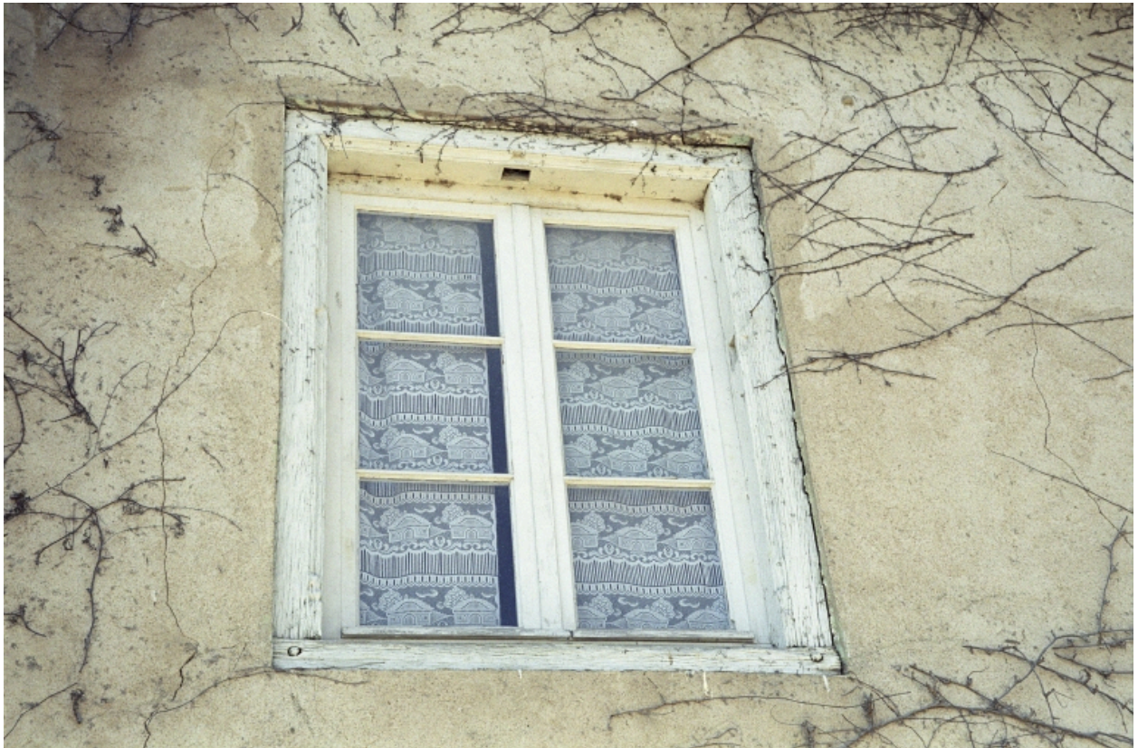
Logis à aître, élévation latérale droite, détail de la baie du premier étage.
