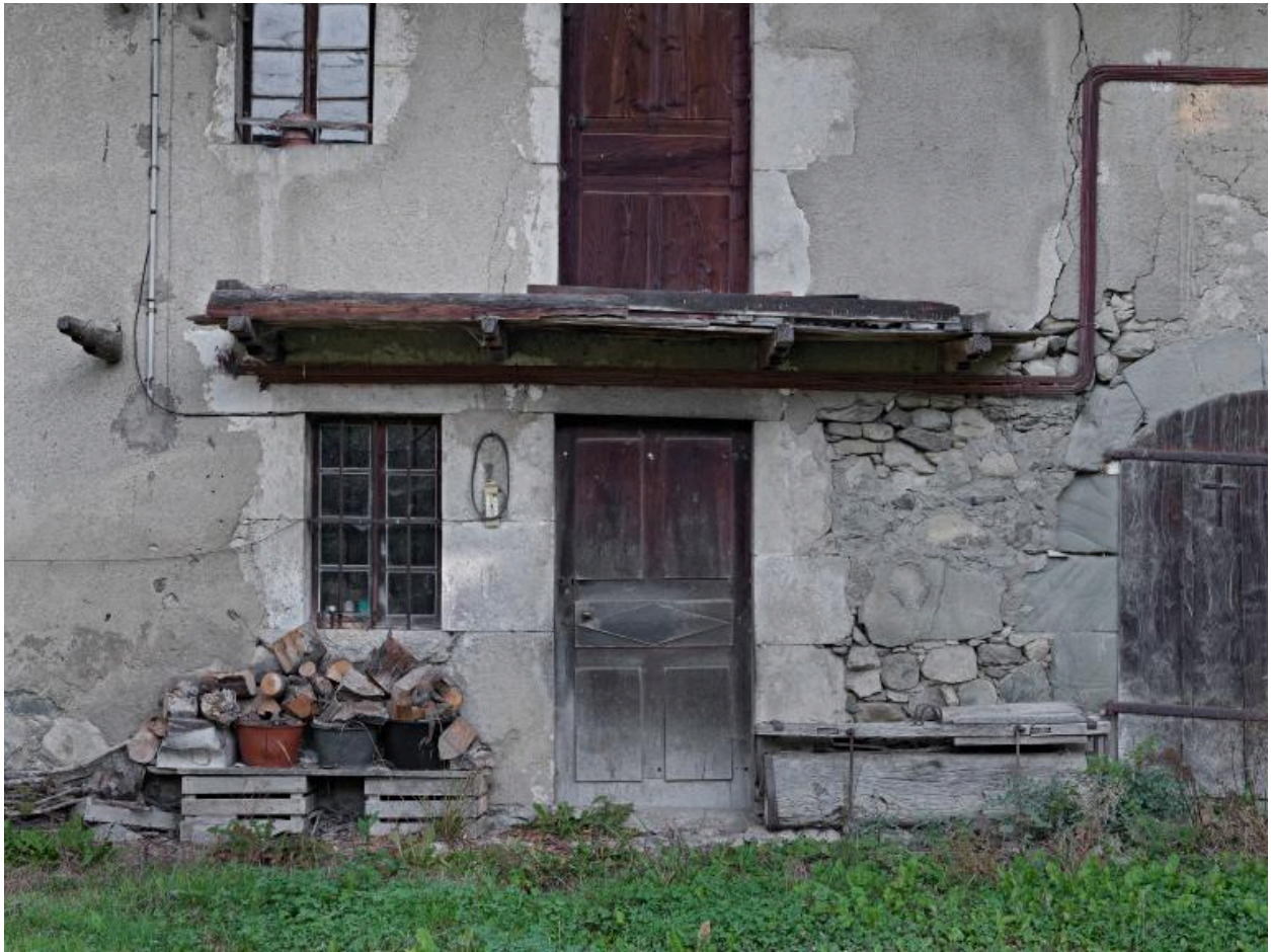
Détail de la façade du logis : encadrements de baies en calcaire, vestige de balcon.
