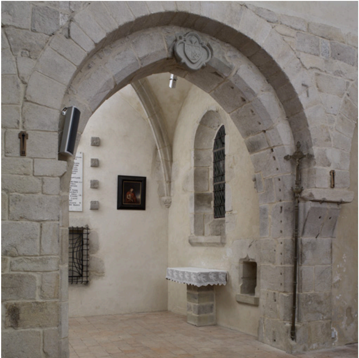
Vue de l'ouverture sur la nef de la chapelle latérale nord.
