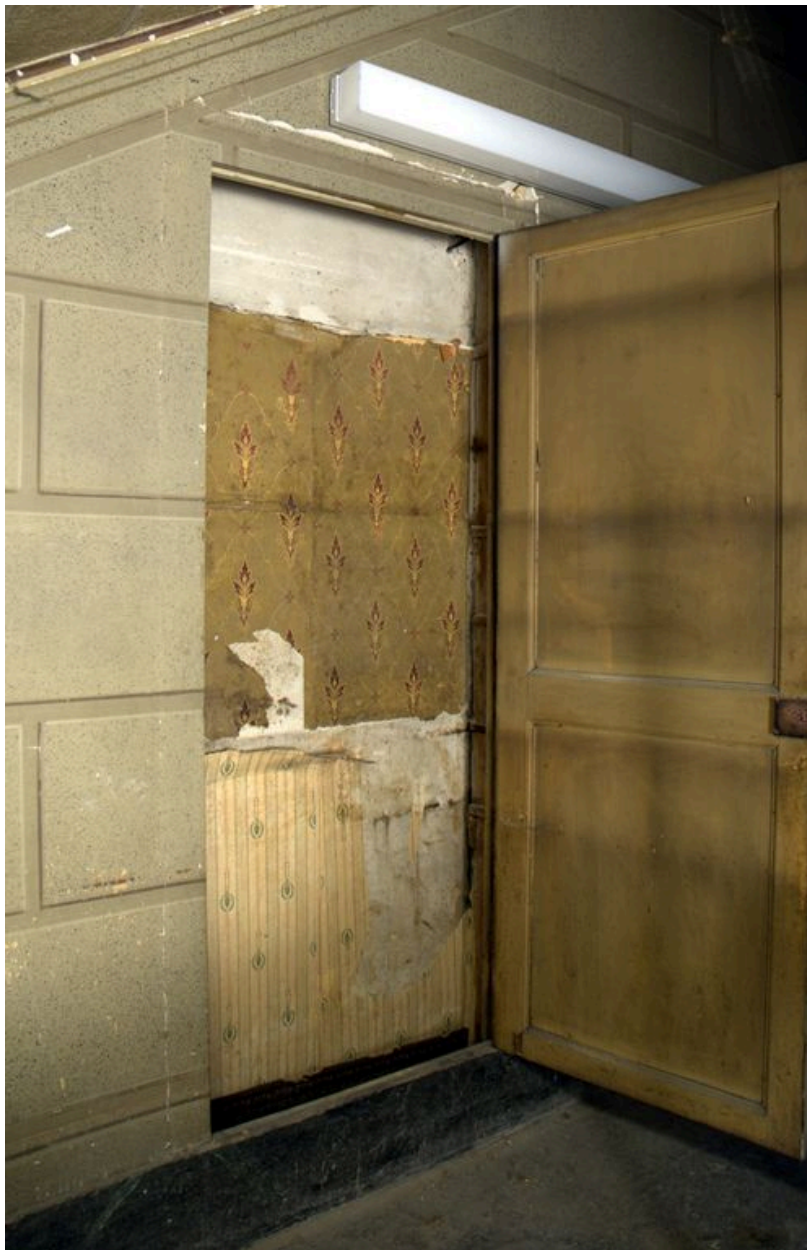
Cage de l'escalier ouest, placard ménagé dans le mur, porte ouverte
