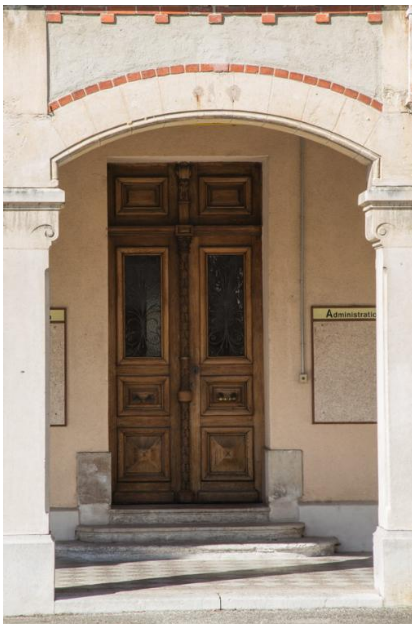
Entrée sur la cour à l'est
