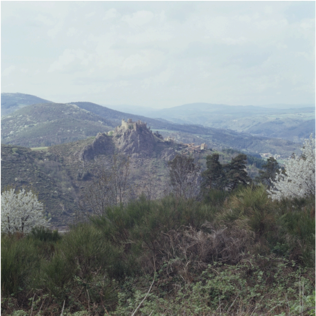
Vue d'ensemble du château depuis le sud-est (commune de Trelins).
