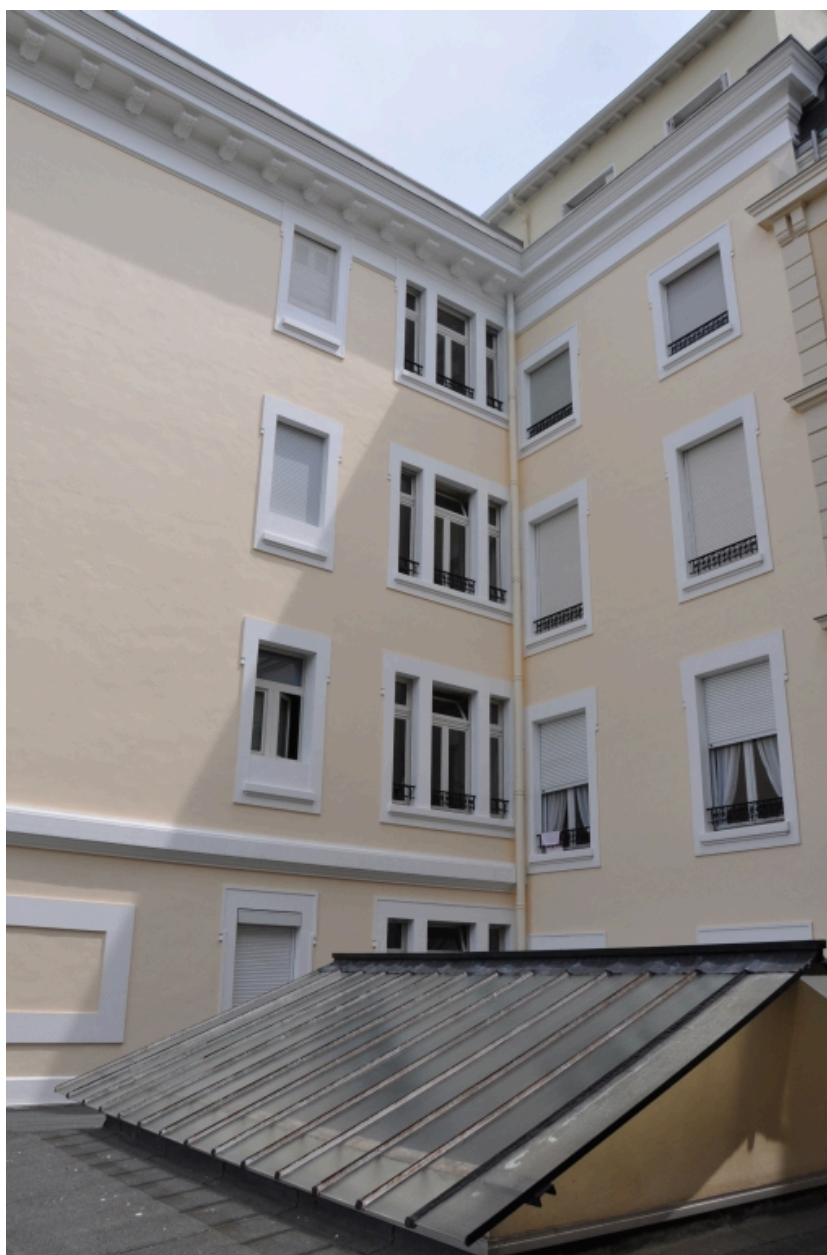
Verrière zénithale du hall
