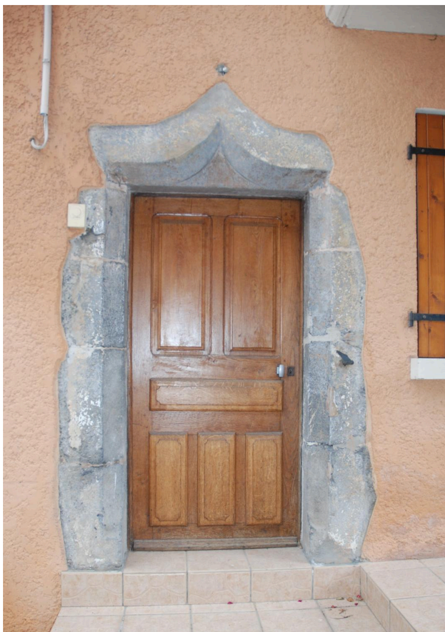
Détail de la porte de 2018 D2 293 (îlot D) : encadrement chanfreiné, linteau en arc infléchi.
