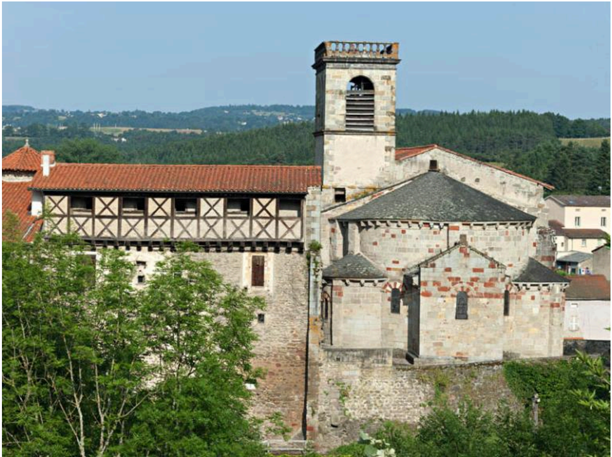
Vue générale du chevet de l'église et d'une partie des bâtiments conventuels.
