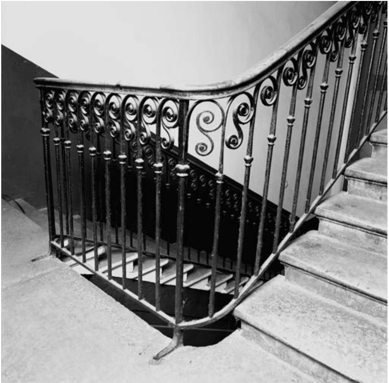
Détail de la rampe d'escalier
