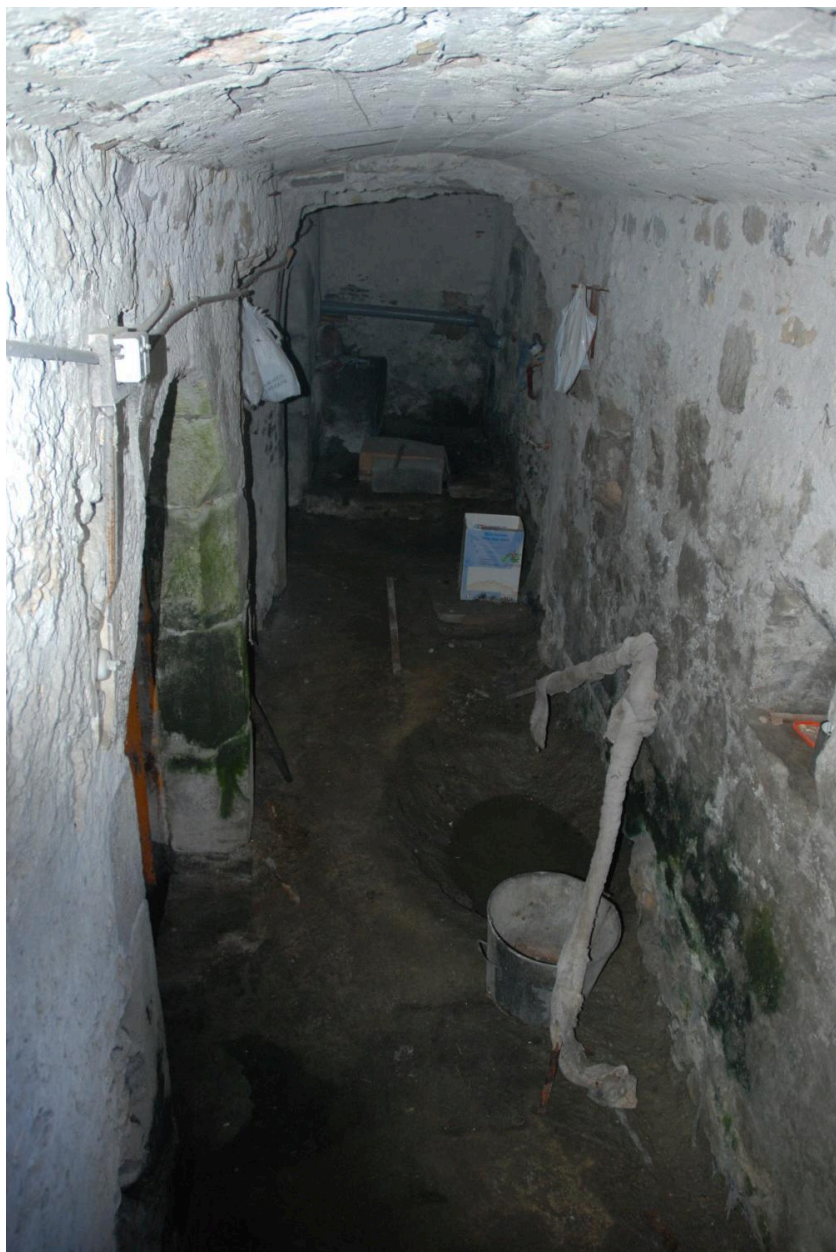
Maison de vigneron (2018 I1 196), vue intérieure : couloir des caves.
