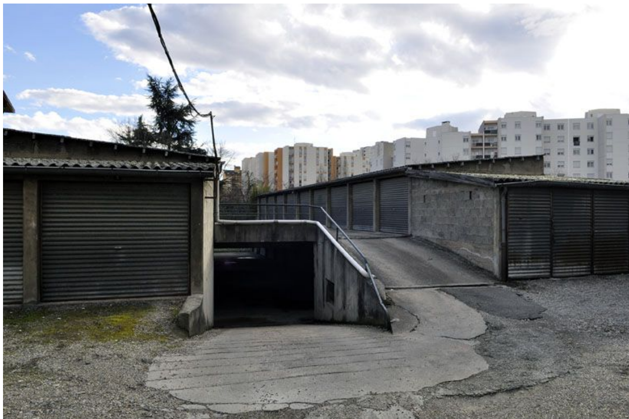
Vue extérieure; arrière de la parcelle, garages.
