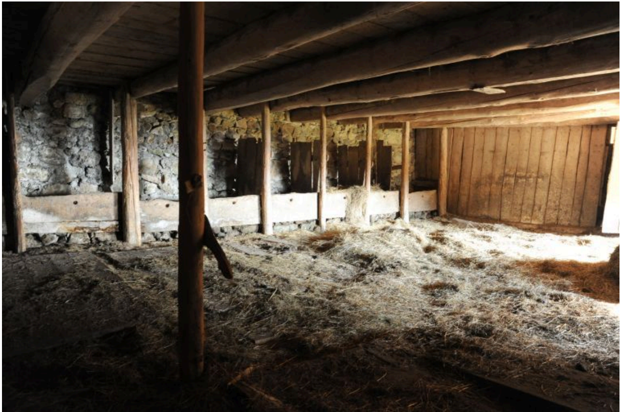
Vue d'ensemble intérieure de l'étable avec cloison bois à l'est.
