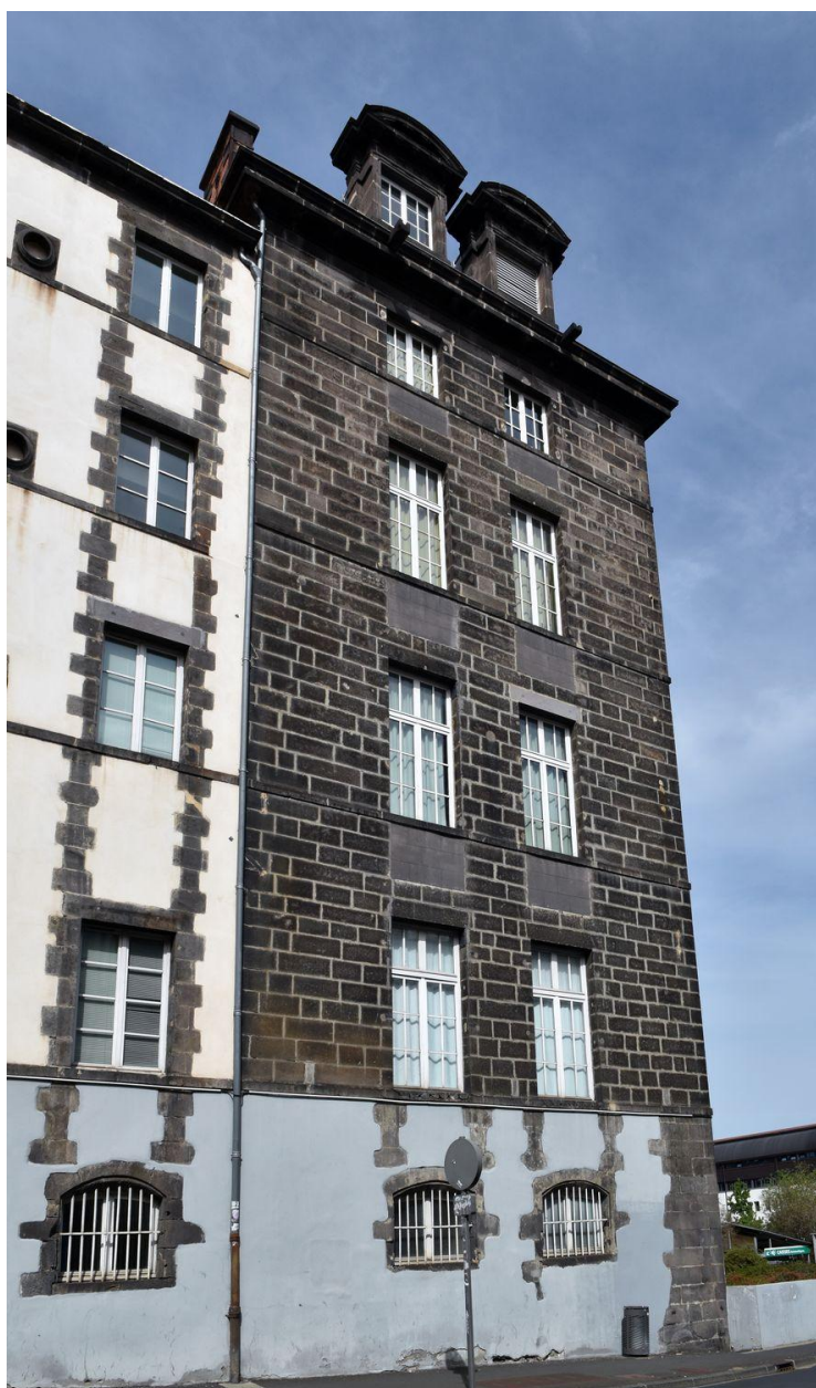
Elévation principale : pavillon est
