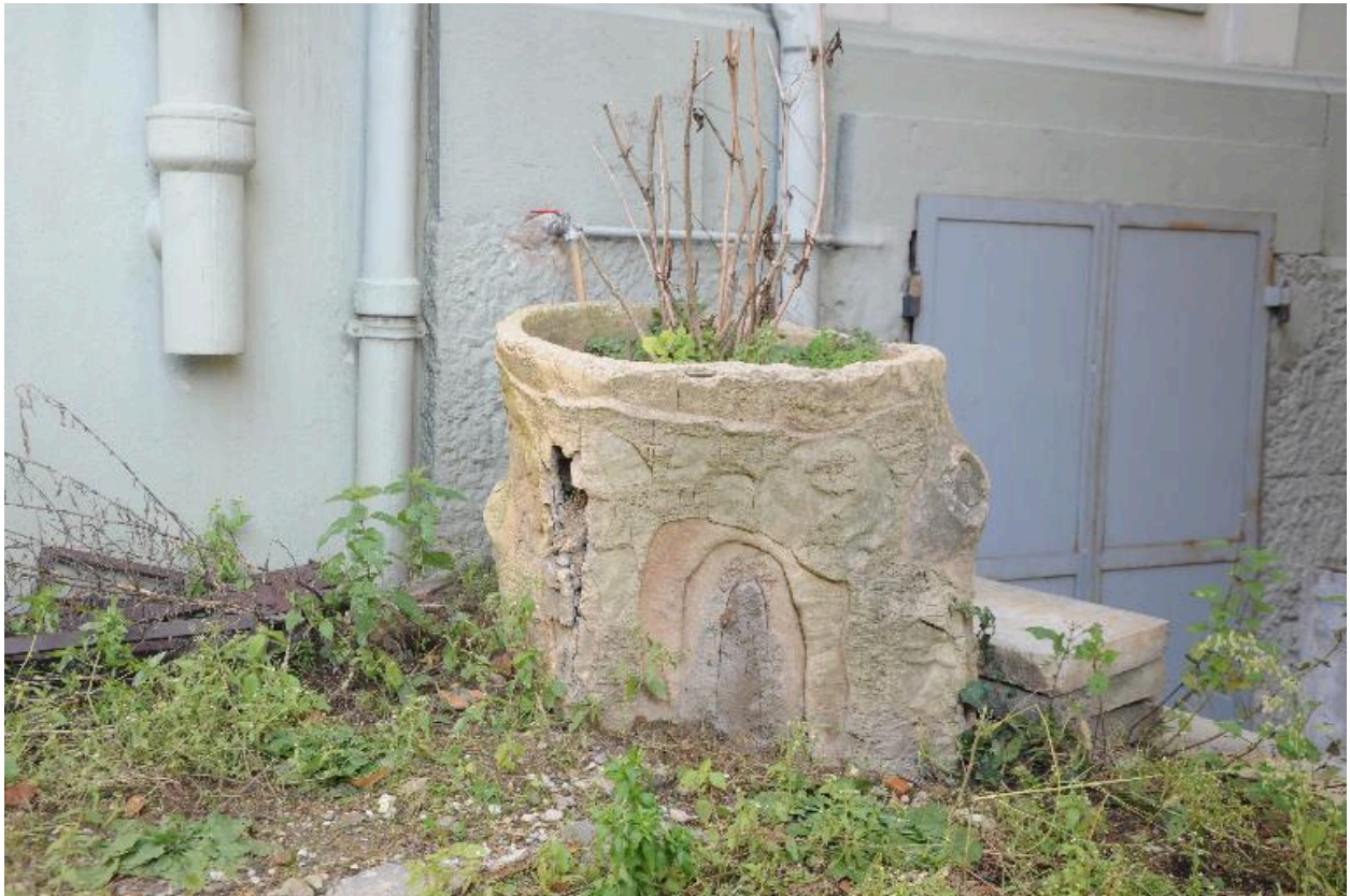
Vestiges de béton armé imitant le bois (rocaille)
