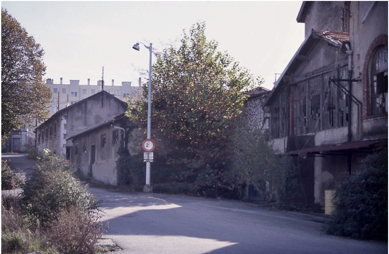
Vue ouest du site
